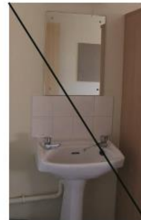
Плохо Раковина с пьедесталом. Фартук из плитки
